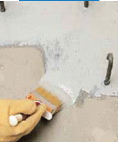
Нанесение Ерогір (Эпорип) кистью на рабочий шов бетонирования
